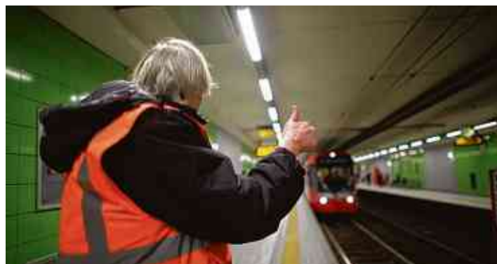
Wegen des fehlenden Brandschutzes in der Haltestelle Poststraße hält Wachpersonal die Station im Auge. Archivfoto: Krasniqi
